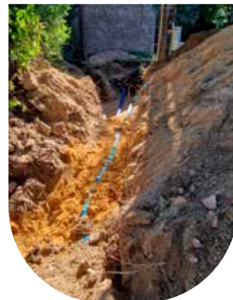
↑ Station de pompage de Noirefontaine
