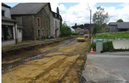
TRAVAUX DE RÉFECTION DES VOIRIES INTÉRIEURES DE BOTASSART
