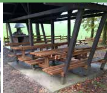
Rénovation de l'abri-barbecue de la « Germaoise » à Corbion
