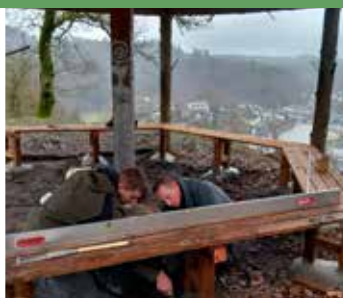
Rénovation des banquettes et des tablettes de la « Ramonette » à Bouillon
